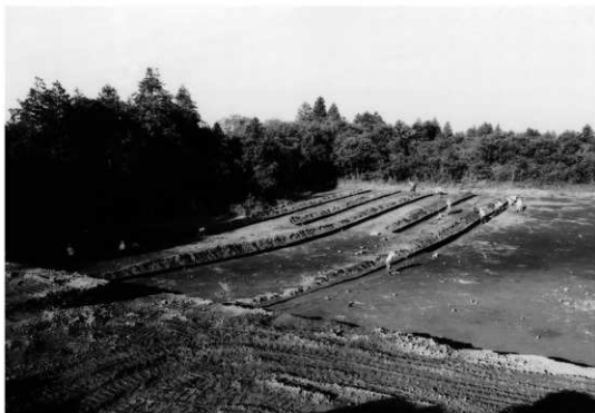
1. 1次確認調査トレンチ設定状況
