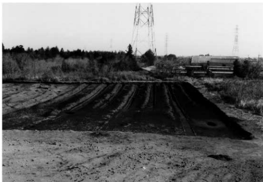
2. 2次確認調査トレンチ設定状況
