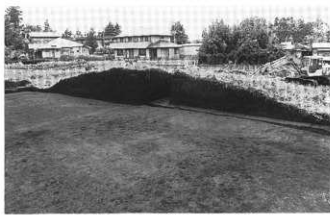
(2) 塚盛土撤去状況 (南半分)
