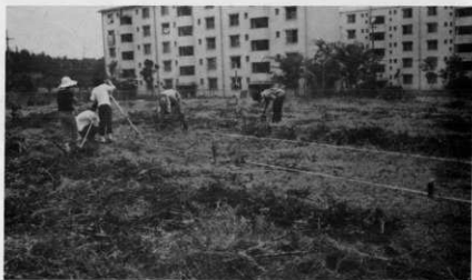
測量、トレンチ設定作業
