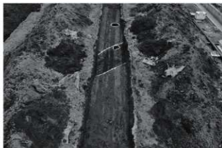
西ノ原遺跡第 170 地点トレンチ 5
