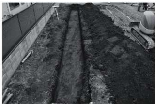
駒林遺跡第33地点トレンチ1
