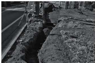
浄禅寺跡遺跡第 46 地点トレンチ 1
