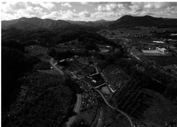
調査区遠景 北上空から
