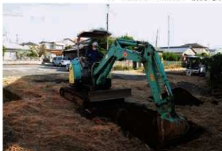
6. 2Tr 重機掘削の様子 (南西から)
