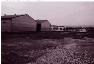
1. 調査前 (南東から)
