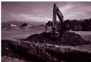
2. 重機稼働 (南西から)
