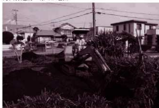
1. 確認調査 重機稼働
