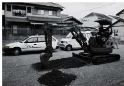
第1図 重機掘削の様子
