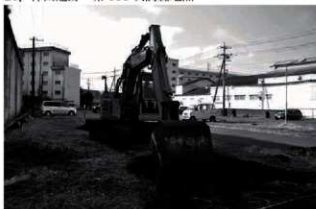
1. 重機掘削の様子
