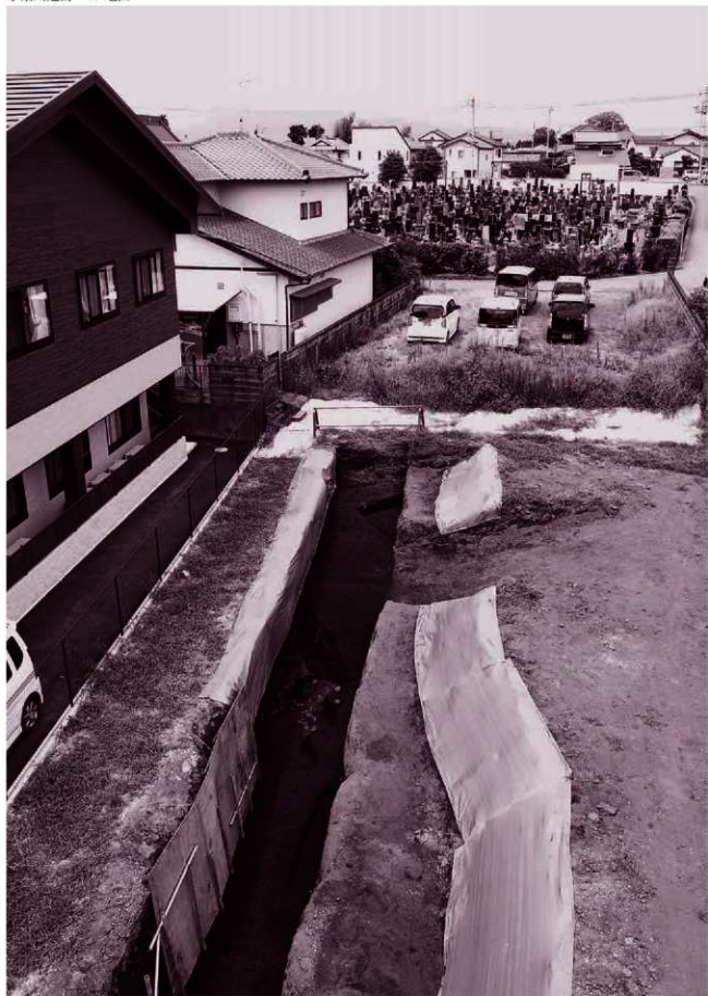
1. 1 工区全景 (東から)
