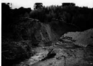
図2 23号台風で決壊したため池
