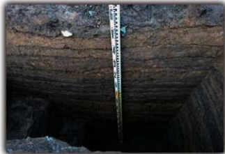
▲ガラミドウで発見した版築（地盤改良工事）の様子
