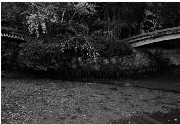
史跡宇佐神宮境内 菱形池中島 護岸検出状況（西から）
