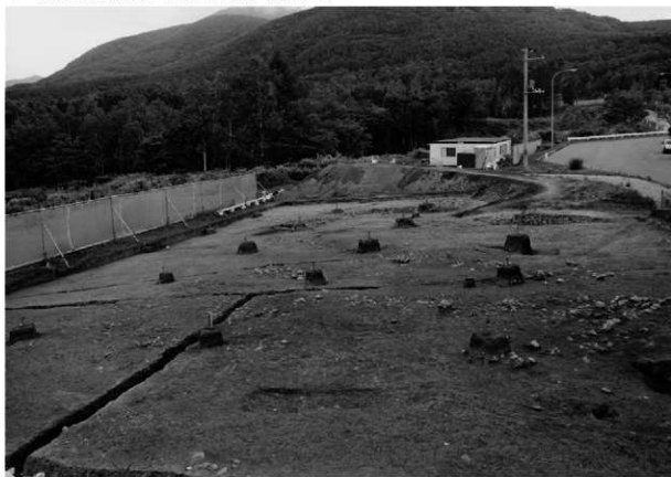
2 板小屋沢遺跡完掘（南東から）
