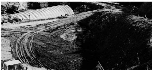
平成16年度 表土除去後状況
