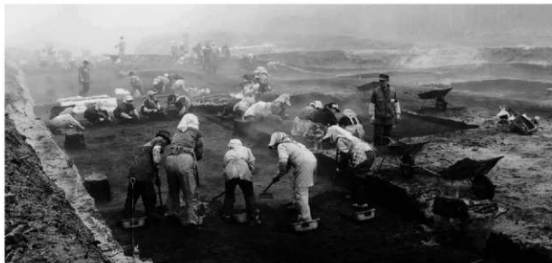
包含層調査状況
