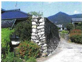
写真 3-1 棚底地区の防風石垣
