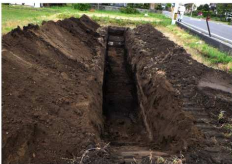
写真42 1 トレンチ全景 (南東から)
