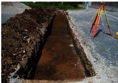
写真2 トレンチ4全景 (南西から)
