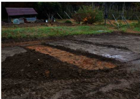
写真21 トレンチ全景 （西から）
