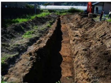
写真8 2トレンチ全景（南東から）
