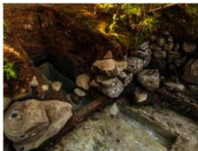
現状の池の石積護岸は、胴木の上に自然石を3~4段ほど積み重ねて構築されていました。裏込として下層に粗砂、上層に粘質土ないし砂質土を用いていますが、この裏込の上層と下層の境界に大きな空隙が生じていました。池の水位が上下することにより浸食が進んだためとみられます。これが原因となって石積護岸が一部崩落していたことがわかりました。本庭園を適切に保存するために早急な対応の必要があります。
