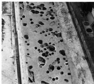
4. D-1地区SB-6全景 (北東から)
