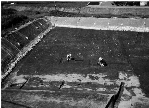
1. 水田部 第1遺構面水田跡1検出状況(西から)
