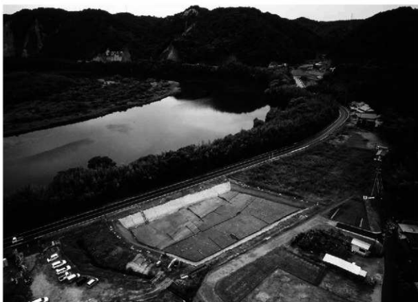
1. 大津地区 遠景(南東から)
