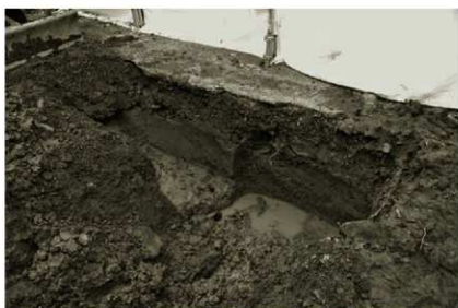
Aトレンチ (南東から)
