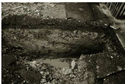
Bトレンチ(東から)
