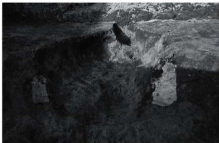
第4号竖穴建物跡電線袖部断ち割り状況
