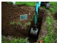
溝（トレンチ）を掘る
