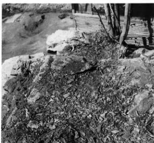
4. 露出した天井石 (東から)
