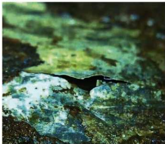
錆表面拡大 (銀板の亀裂部分)
