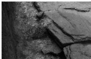
第5号墳 蓋石北側目地粘土被覆状況 (西から)
