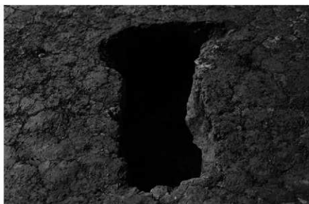
第 5 号火葬施設
