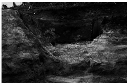
谷部 調査終了状況②
