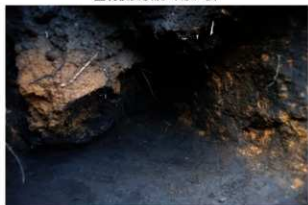
玄室右側天井陥没状況（東から）
