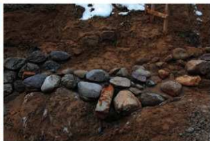
石垣A部分2段目
