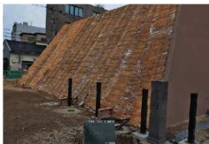
土居法面コモ設置状況
