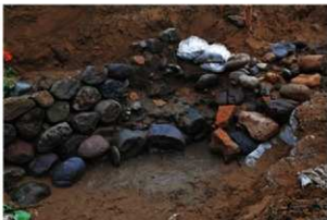
石垣 A 部分 4 段目
