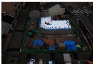
軽量盛土工 (EPS) 設置状況
