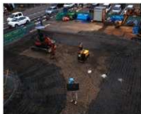
ジオグリッド設置状況
