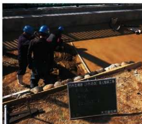
土系舗装施工状況
