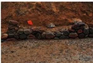
石垣 4 B 部分撤去状況
