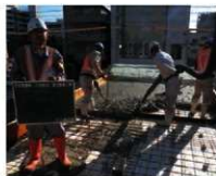
コンクリート床版施工状況
