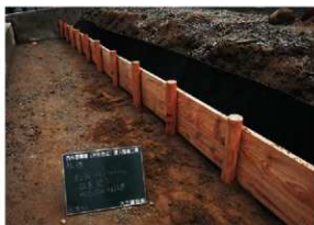
板柵設置状況
