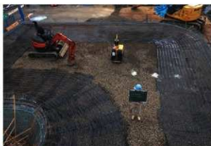
ジオグリッド工完了
