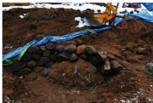
石垣A部分1段目
