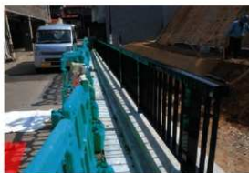
立入禁止柵施工完了
