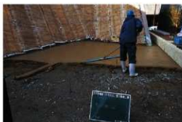
土系舗装施工状況
