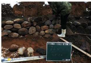
石垣積増し状況
