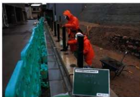
立入禁止柵施工状況
