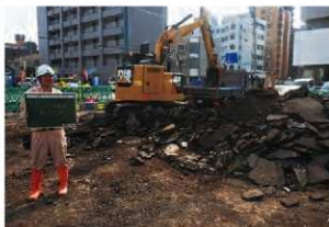
アスファルト舗装撤去
