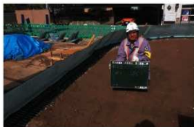
植生シート設置状況
