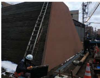
壁面吹付完了
