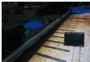
植生シート設置状況
