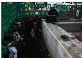
コンクリート擁壁（上流側）設置状況
