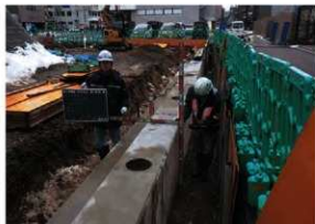
コンクリート擁壁（北側）設置状況
