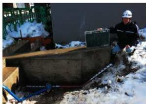
コンクリート擁壁（下流側）設置状況
