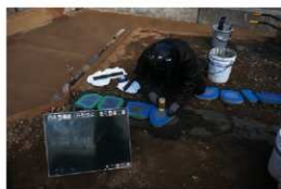
石垣の変遷表示施工状況
