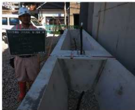
植樹枠設置状況
