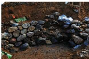
石垣 A 部分撤去状況と石垣 5（下）、7（左上）
