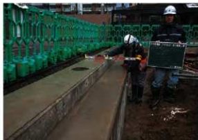
コンクリート擁壁（西側）設置状況
