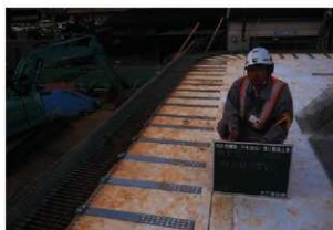
土居壁面材設置状況
