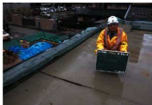
床板コンクリート設置完了
