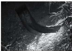
L 調査状況
