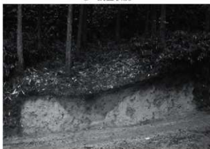
I南側 調査状況
