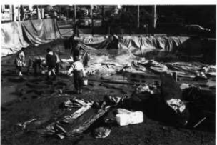
8. 調査区の冠水状況
