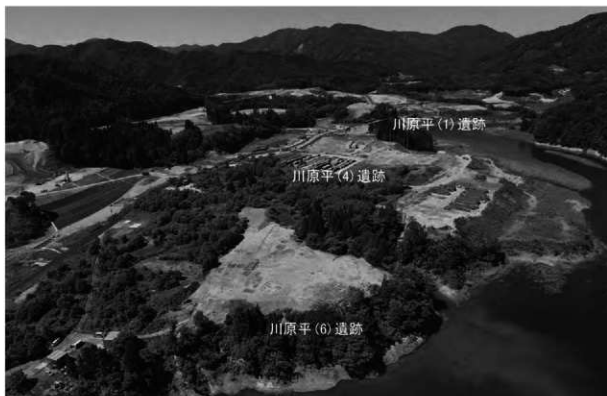
調査区遠景（東から）
