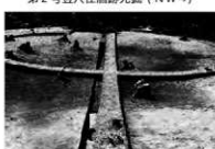
第2号竪穴住居跡表土掘削後 (NE→)
