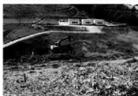
南側沢地の調査状況
