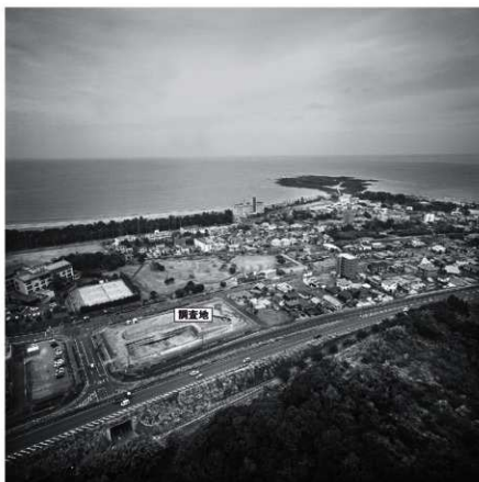
調査地遠景（青島本島を望む）【西から】
