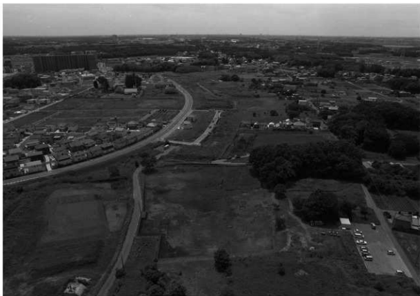
平成26・27年度調査区遠景（北から）
