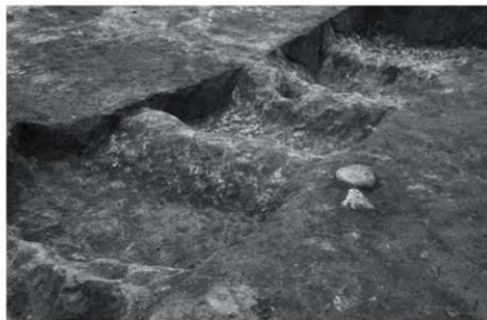
第 1 号 道 路 跡 波 板 状 凹 凸 確 認 状 況
