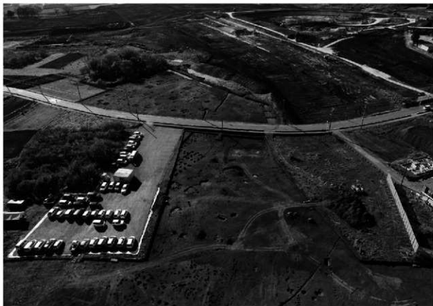
調査区遠景（東方向から）
