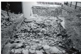
土居側石垣裏込・SK102
