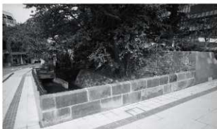
写真5 宮内橋詰めの西外惣構遺構
