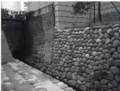
復元整備された東内惣構跡枯木橋詰道構
