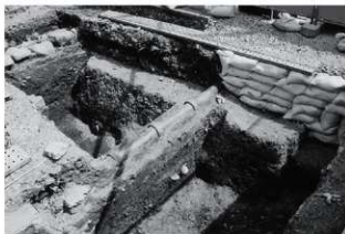
Ⅰ期堀の法面
