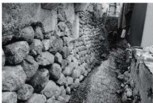
土居側石垣と堀外側石垣3、新橋
