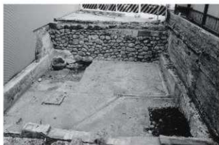
地下室調査区と地下室石垣
