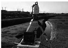
写真3 地上レーザー計測状況
