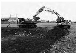
写真1 重機による表土掘削
