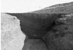
4区大型溝状遺構 D セクション
