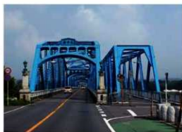
現在の太田橋
