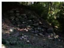
高さ3メートルに及ぶ石垣があったと考えられる箇所(西Ⅱ 東側)
