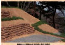
石壘・土壘の保護の盛土及び植生土のうの設置 (群馬県太田市 史跡金山城跡) (文化財だより No. 6)
