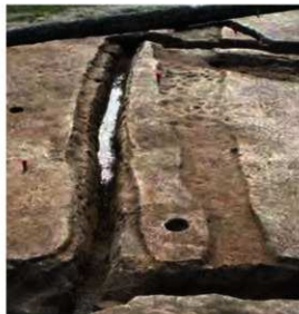
第21、22号溝跡(東から)
