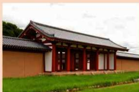
▲ 復元された東院南門(南西から)
