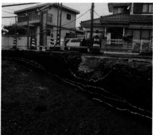
3. A区NR-1土層 (南西から)
