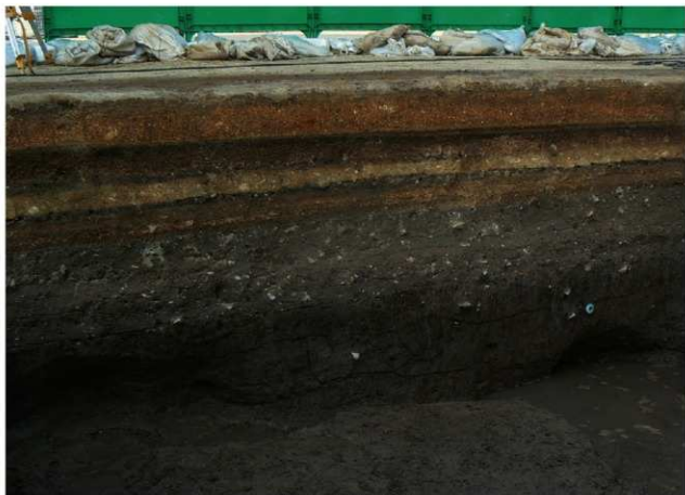
A 調査区北側電源開断面
