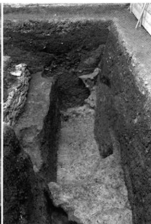
2 北部土取り跡（東から）
