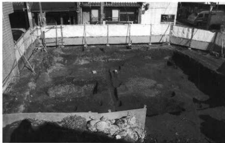
図5 第1面全景（南から）
