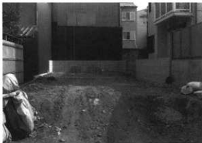
図3 調査前全景(南から)
