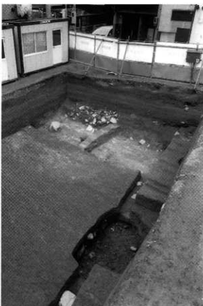
2 第3面全景（南東から、奥が溝54）
