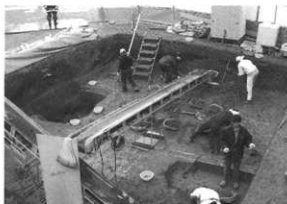
图23 調査風景 (北西から)
