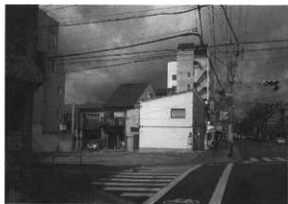
图22 調査前全景 (南から)
