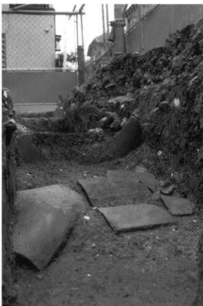
3 北廊Ⅰ期側面瓦貼り付け状況 (西から)
