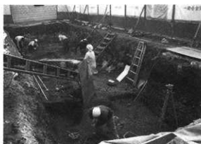
図48 調査風景 (北から)
