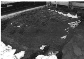
図8 埋め戻し状況（南西から）
