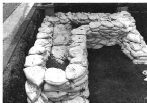
図7 埋め戻し状況（西から）
