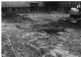
図79 調査前全景 (北西から)
