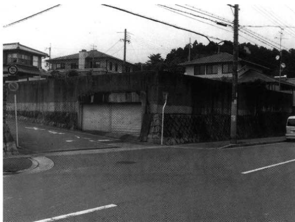
1 調査地（南東から）
