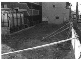
図47 調査前全景 (北から)
