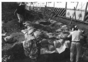
図26 埋め戻し状況（東から）
