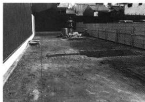
図3 調査前全景（北から）
