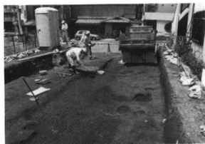
図11 作業風景（南から）
