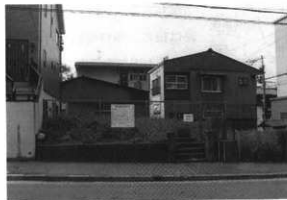
図10 調査前全景（北から）
