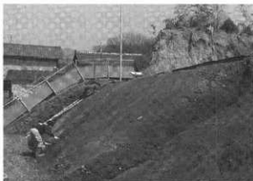
図57 作業風景（南から）
