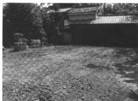
図29 調査前全景（南西から）
