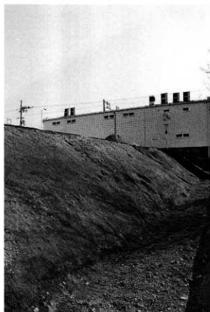
2 土塁(北西から)
