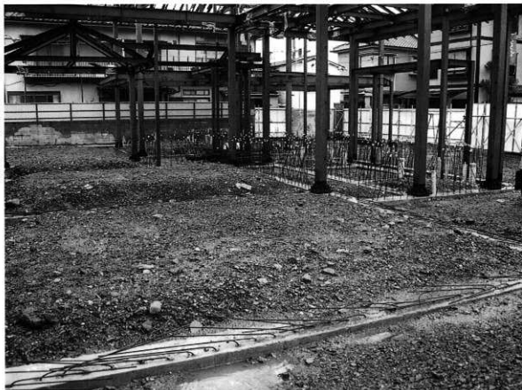
1 調査前全景（南から）
