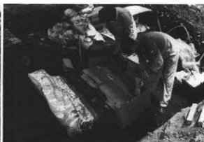
図4 瓦積取り上げ作業
