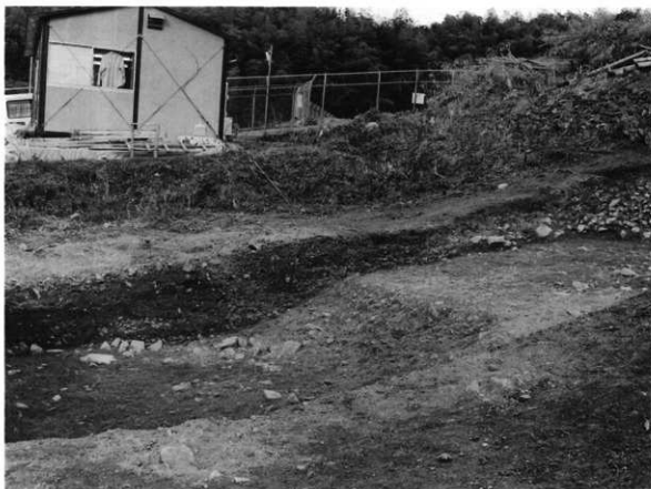
1 下段 北グリッド全景 (南南西から)
